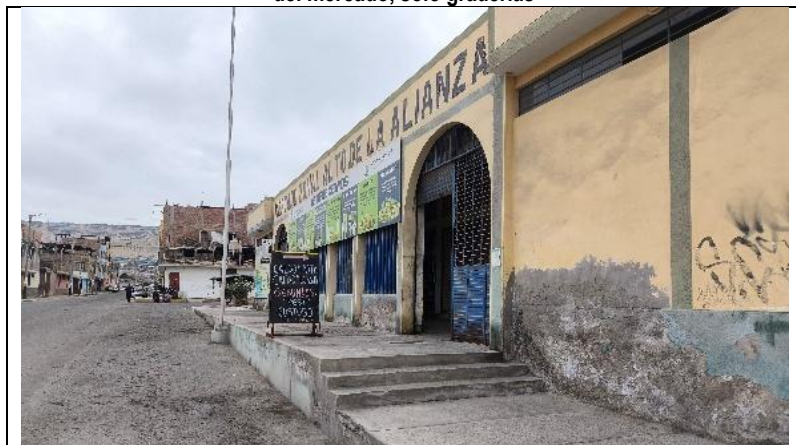
Imagen n.° 13 No existencia de rampa de acceso en el ingreso principal del mercado, solo graderías
